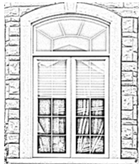
Fenêtre à arc surbaissé
