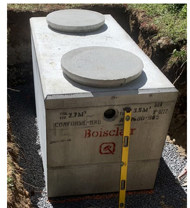
Fosse septique en béton.
